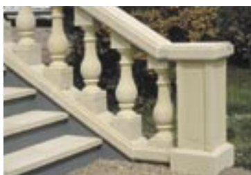
Balustrades en rampe d'escalier.
