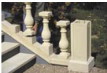
Pose du balustre sur limon d'escalier.
