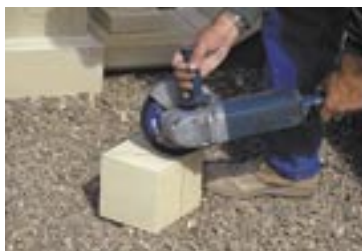
Ajustage des dès par troncçonnage.
